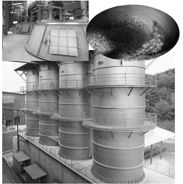
대성GMTech의 Shaft kiln
